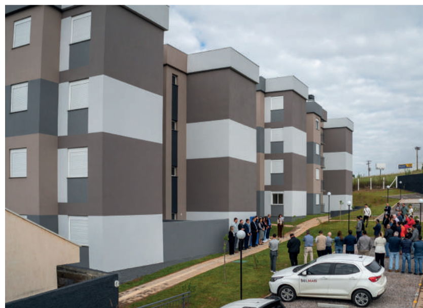
Residencial Vitória II, localizado no Loteamento Santorini
